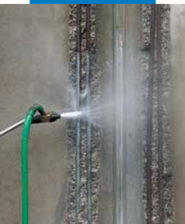
Pulizia dei ferri con idrosabbatura
