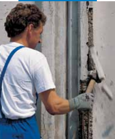
Demolizione del calcestruzzo degradato
