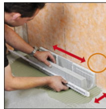
rif. 1. allineare il supporto canalina
