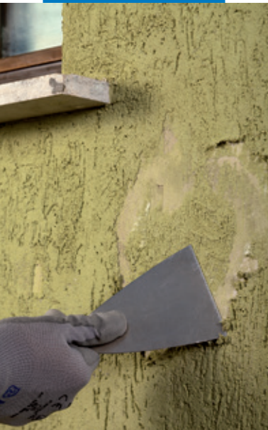
Rimozione del rivestimento plastico non aderente
