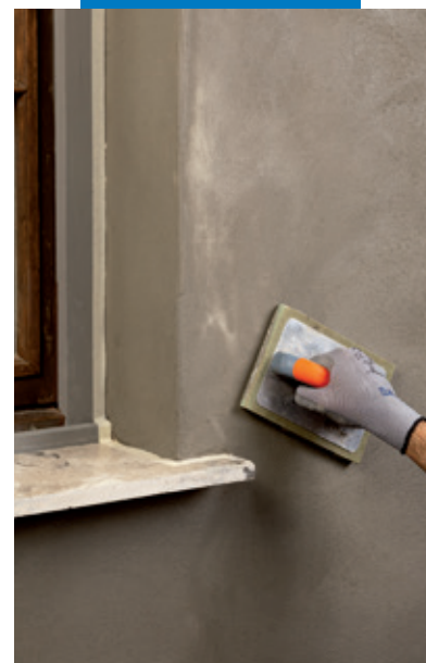
Frattazzatura di Planitop 210
