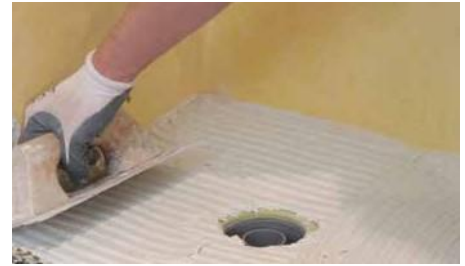
3. Stendere uno strato sottile di cemento colla con la spatola di 4 mm.
