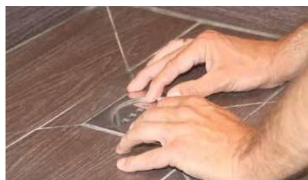
10. Mettere la sigillatura (solamente nel caso in cui l'installazione non sia collegata al contenitore sifonico centrale) e poi la griglia. La nostra doccia è già pronta, completamente finita e con l'impermeabilizzazione pienamente garantita.
