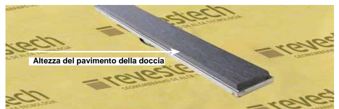
3. Inserire la griglia con la striscia incollata dentro la vaschetta in modo da poter determinare la quota del pavimento. Procedere alla posa del pavimento iniziando dalla griglia rivestita.
