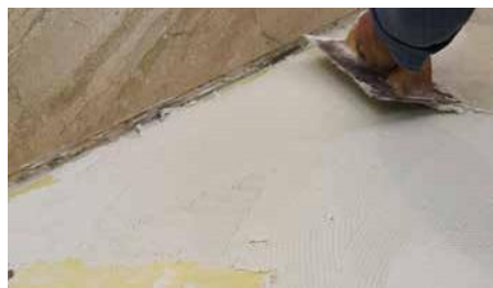
8. Stendere cemento colla con la spatola di 4 mm.
