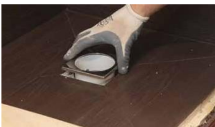
10. Mettere la sigillatura (solamente nel caso in cui l'installazione non sia collegata al contenitore sifonico centrale) e poi la griglia. La nostra doccia è già pronta, completamente finita e con l'impermeabilizzazione pienamente garantita.
