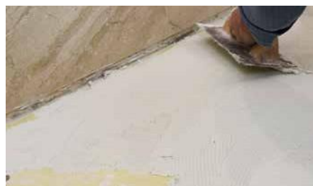
8. Stendere cemento colla con la spatola di 4 mm e collocare la vaschetta lineal sopra il sifone.
