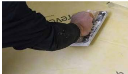
5. Controllare che la lamina sia ben stesa ed eliminare le eventuali bolle d'aria generate utilizzando la spatola.
