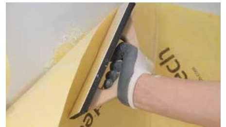
6. Rivestire la parete con la lamina Revestech DRY50 sovrapponendola per almeno 5 cm.
