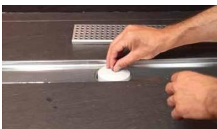
10. Mettere la sigillatura (solamente nel caso in cui l'installazione non sia collegata al contenitore sifonico centrale) e poi la griglia. La nostra doccia è già pronta, completamente finita e con l'impermeabilizzazione pienamente garantita.
