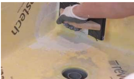
7. Formare gli angoli piegando la lamina. Per una finitura perfetta utilizzare gli accessori prefabbricati CORNER IN e CORNER OUT.
