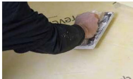
5. Controllare che la lamina sia ben stesa ed eliminare le eventuali bolle d'aria generate utilizzando la spatola.
