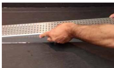
10. Mettere la sigillatura (solamente nel caso in cui l'installazione non sia collegata al contenitore sifonico centrale) e poi la griglia. La nostra doccia è già pronta, completamente finita e con l'impermeabilizzazione pienamente garantita.
