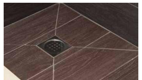
10. Mettere la sigillatura (solamente nel caso in cui l'installazione non sia collegata al contenitore sifonico centrale) e poi la griglia. La nostra doccia è già pronta, completamente finita e con l'impermeabilizzazione pienamente garantita.
