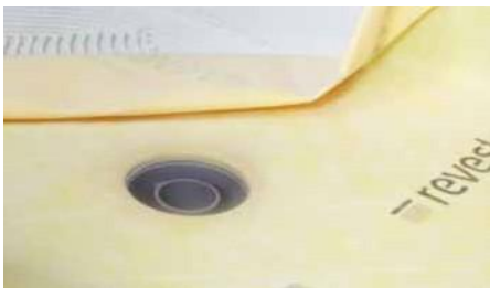
4. Stendere la lamina sopra il cemento colla.
