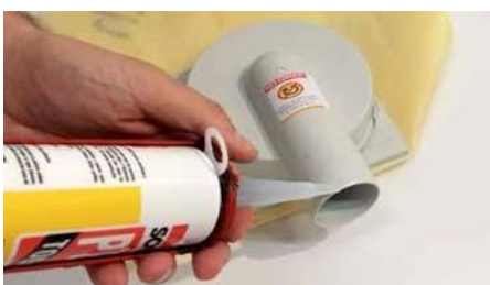
1. Stendere un adesivo polimero MS sull'uscita del sifone Sumi FLAT.
