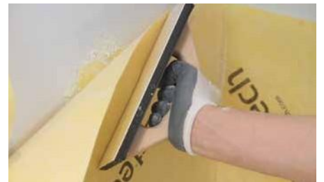
6. Rivestire la parete con la lamina Revestech DRY50 sovrapponendola per almeno 5 cm.
