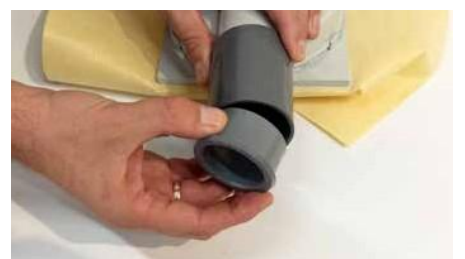
3. Se è necessario un adattamento, incolliamo la riduzione Ø50-40H e la inseriamo nel raccordo.
