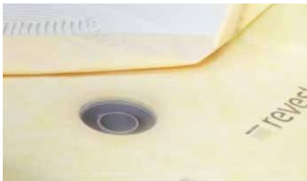
4. Stendere la lamina sopra il cemento colla.
