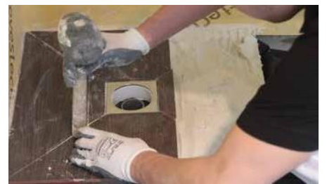
9. Piastrellare pavimento e pareti.
