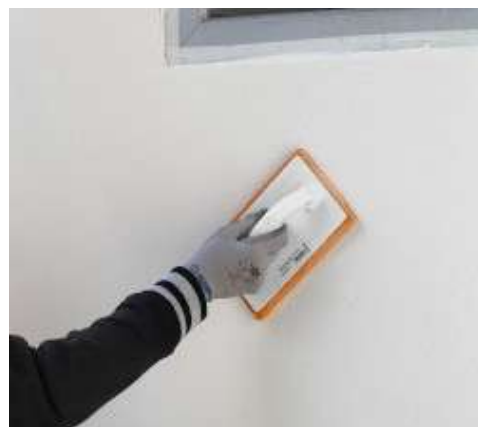
Frattazzatura di Planitop 525
