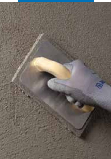
Frattazzatura di Planitop 517
