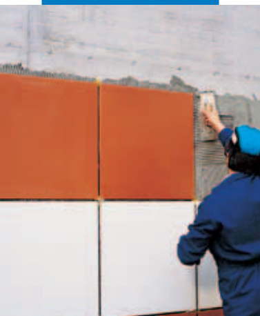
Posa di grandi formati con Kerafloor T + Isolastic
