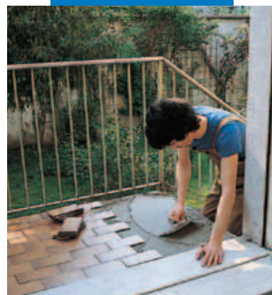
Rasatura impermeabilizzante e successiva posa con Kerabond T + Isolastic
