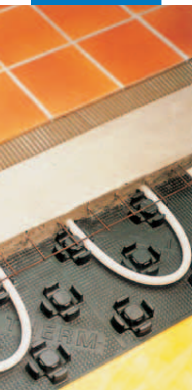
Posa di ceramica su pavimenti riscaldanti
