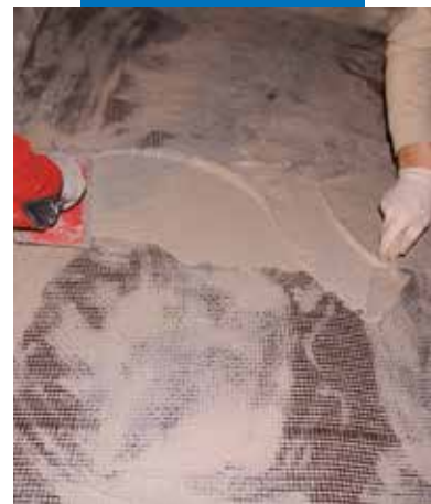
Applicazione del secondo strato di Planitop HDM Restauro
