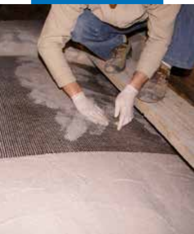
Posizionamento di Mapegrid B 250
