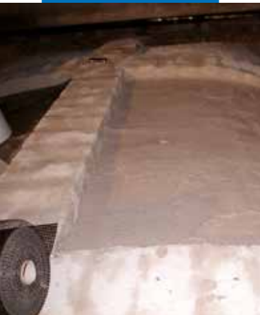
Applicazione del primo strato di Planitop HDM Restauro
