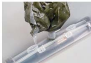
8. Colata della resina fino al completo riempimento
