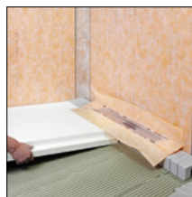
rif. 3. posizionare il pannello di livellamento
