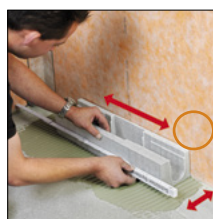
rif. 1. allineare il supporto canalina
