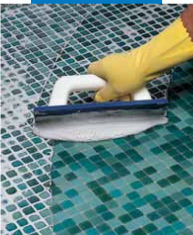
Stuccatura di mosaico vetroso con Keracolor FF impastato con Fugolastic
