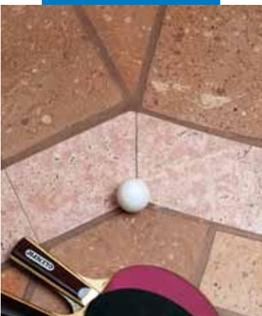
Pavimento di cotto levigato in opera fugato con Keracolor GG impastato con Fugolastic
