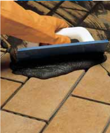
Stuccatura di pavimento esterno in Klinker con Keracolor GG impastato con Fugolastic
