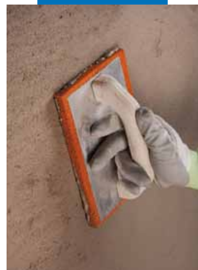
Frattazzatura di Planitop Rasa & Ripara
