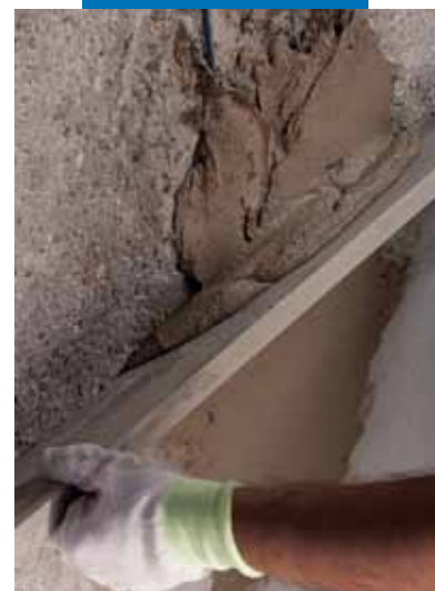
Staggiatura di Planitop Rasa & Ripara
