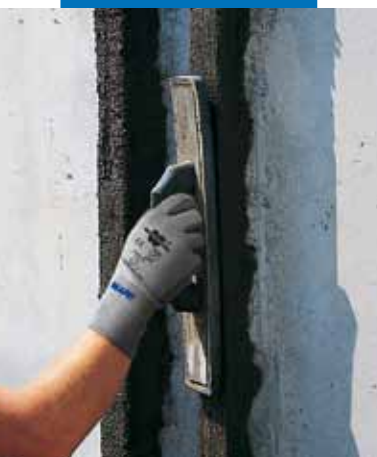
Rifinitura con frattazzino
