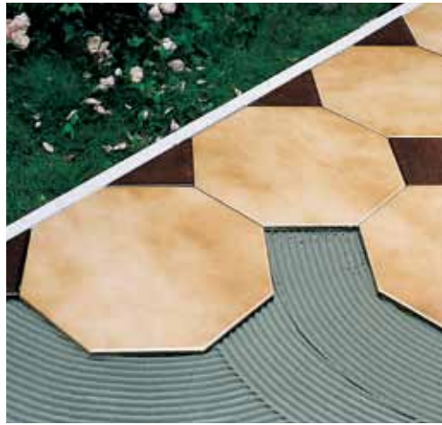
Posa di pavimento esterno
