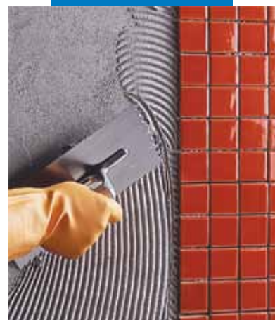
Posa a rivestimento di mosaico ceramico
