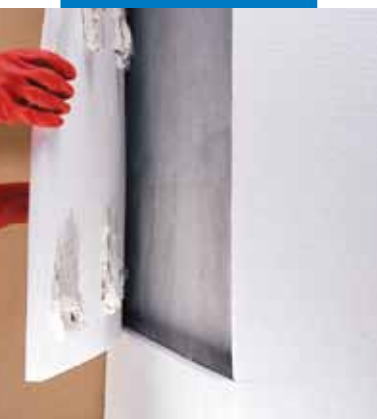
Incollaggio a punti di pannelli in materiale isolante
