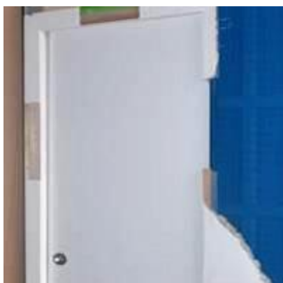
Controtelaio per porte scorrevoli a scomparsa
