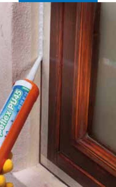
Sigillatura elastica di giunti di costruzione
