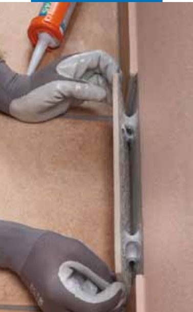
Incollaggio elastico di elementi costruttivi
