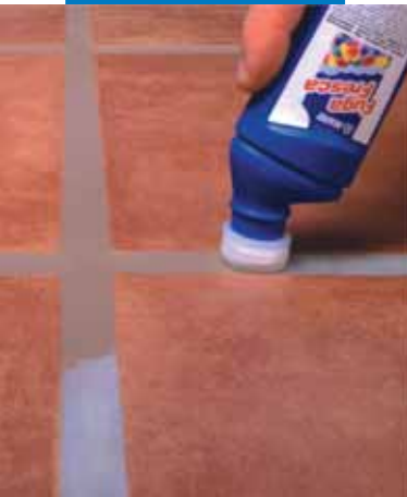
Trattamento con Fuga Fresca su pavimento in cotto
