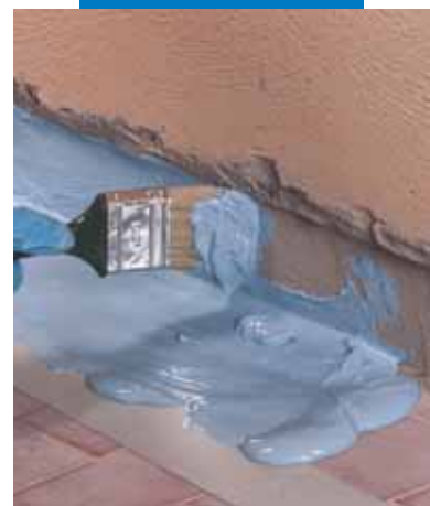
Stesura a pennello di Mapelastic® AquaDefense nel raccordo parete-pavimento, prima dell'applicazione di Mapeband
