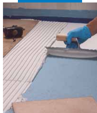
Incollaggio delle piastrelle su Mapelastic® AquaDefense
