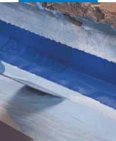
Applicazione di Mapeband nel raccordo parete-pavimento con Mapelastic® AquaDefense
