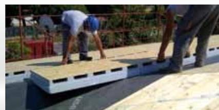
Per quanto concerne la posa dei pannelli, nel caso del monodirezionale, si dovrà disporre il pannello **Winpor** con il lato lungo parallelo alla linea di gronda in modo da ottenere le camere di ventilazione aperte e continue verso il colmo.
