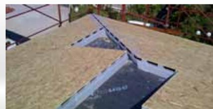
I pannelli **Winpor** si possono sagomare con una normale sega da legno e possono essere sigillati nelle linee di giunzione con **nastro butilico PORON**.
