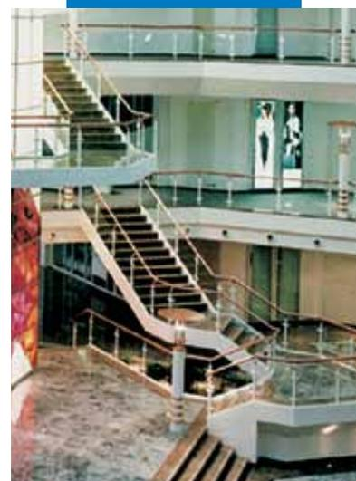
*Esempio di posa di rivestimenti in ceramica o marmo su una struttura di metallo (scala)*
