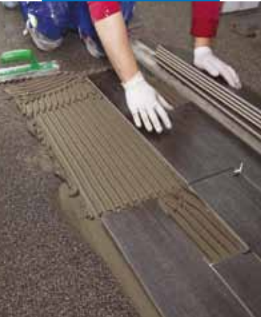
Posa di grès porcellanato su Mapesonic CR con Keraquick S1 zero + Latex Plus
